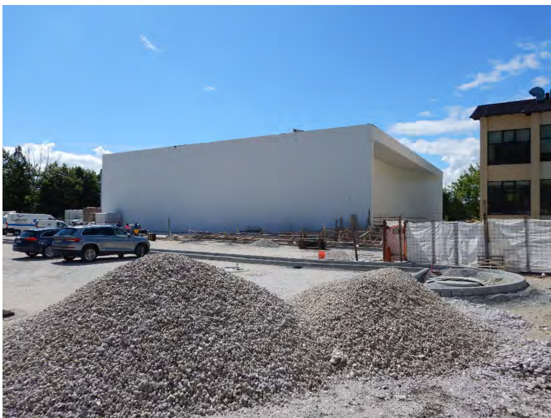
Slika 9. Gradnja parkirišča (osebni arhiv).
