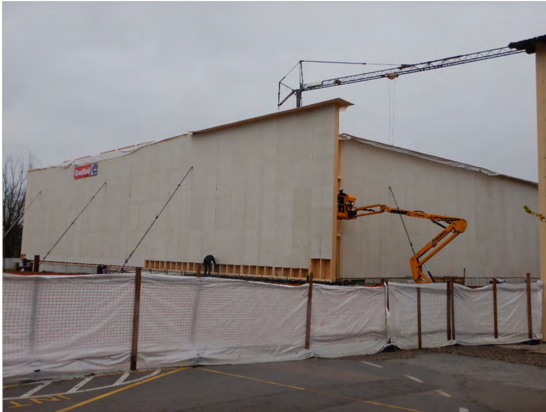
Slika 4. Montažni sklopi nadgradnje (osebni arhiv).
