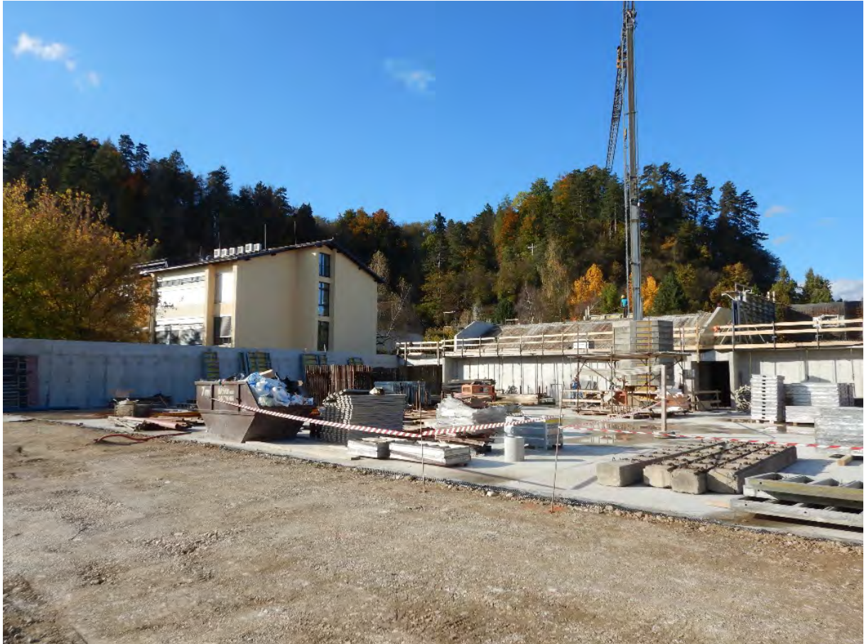
Slika 3. Betoniranje osnovne konstrukcije (osebni arhiv).
